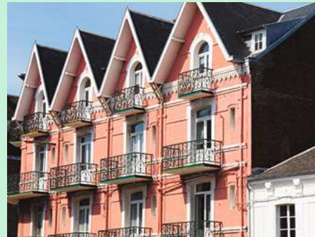
Les villas emblématiques de la station balnéaire
